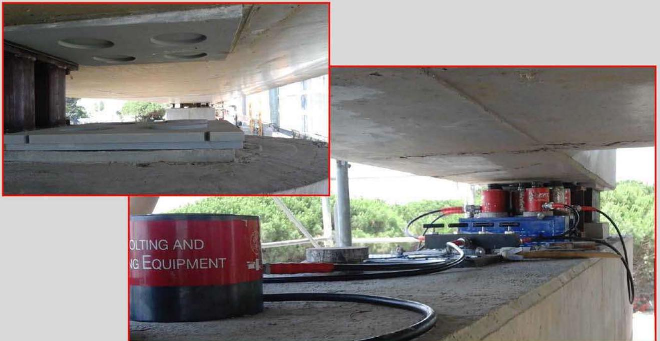
sia in edifici danneggiati dal sisma che su ponti e viadotti, con tecnica di inserimento, sia alla base che con taglio di strutture verticali in elevazione.
