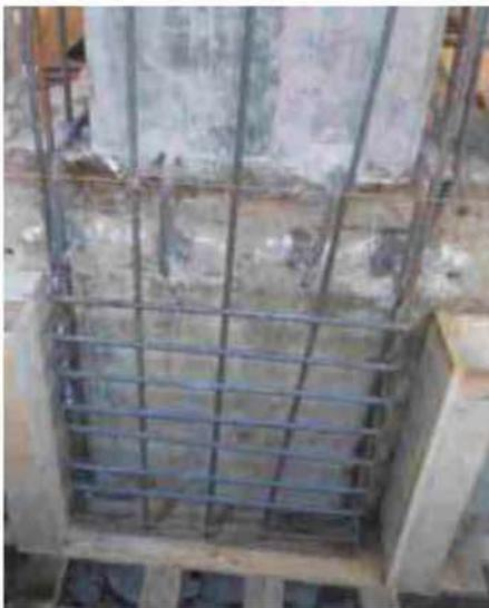
**Figura 11** - Intervento di adeguamento delle travi di fondazione (© Kaltha s.r.l.).
