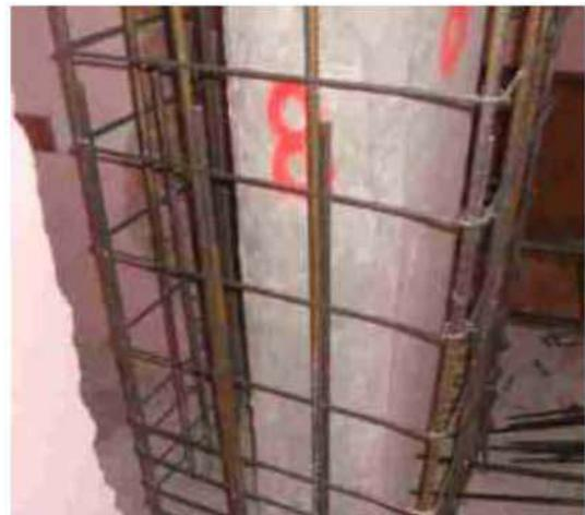
**Figura 12** - Intervento di adeguamento dei pilastri del piano cantinato (© Kaltha s.r.l.).
