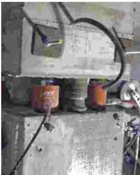
**Figura 15** - Fase operativa taglio pilastri: vista a taglio completato (© Kaltha s.r.l.).
