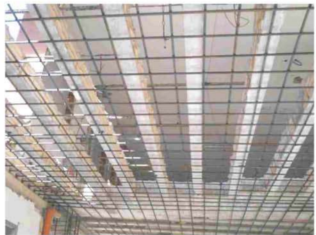
Figura 15. Intervento di adeguamento dell'impalcato sovrastante il sistema isolamento: (a) esempio di esecutivo di cantiere; (b) documentazione fotografica. © Kaltha s.r.l.
