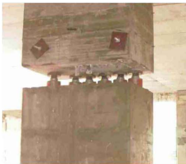
Figura 19. Fase operativa taglio pilastri: vista a taglio completato. © Kaltha s.r.l.
