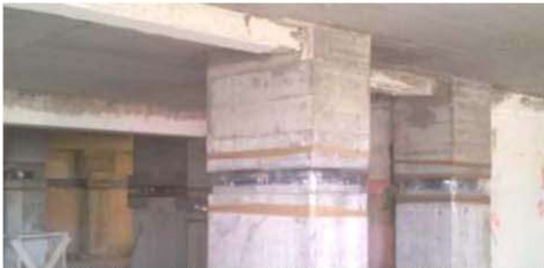
Figura 21. Viste dei dispositivi installati. © Kaltha s.r.l.
