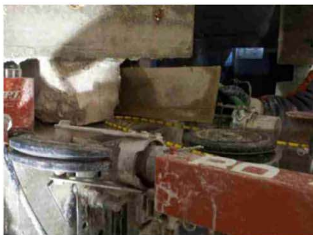
Figura 18. Fase operativa taglio pilastri: operazione conclusiva del taglio con filo diamantato. © Kaltha s.r.l.
