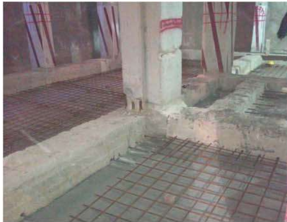
Figura 13. Intervento di adeguamento delle strutture di fondazione: (a) esempio di esecutivo di cantiere; (b) documentazione fotografica. © Kaltha s.r.l.
