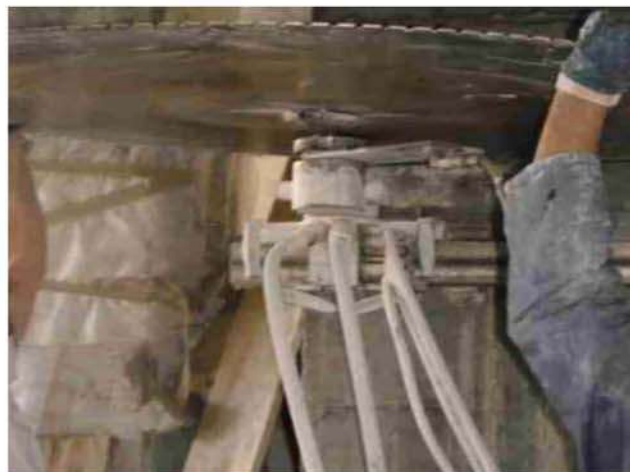
Figura 17. Fase operativa taglio pilastri: estrazione lama diamantata. © Kaltha s.r.l.
