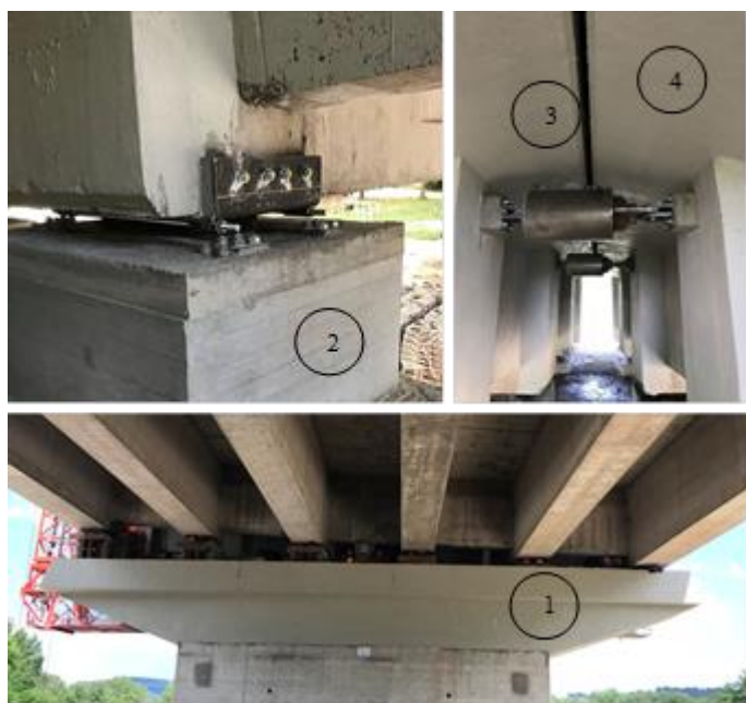
Figure 24. Structural repair works / Interventi di ripristino strutturale.
