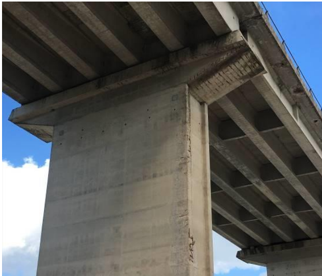
Figure 8. Photo of a pier / Foto di una pila.
