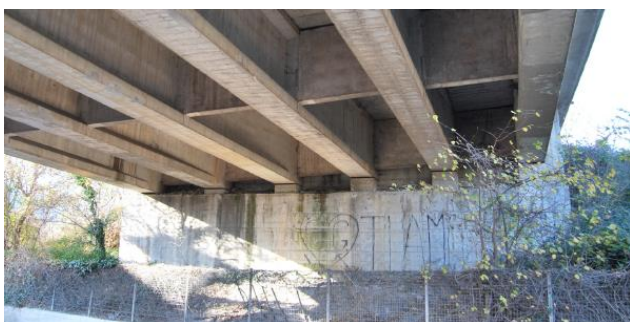
Figure 9. Photo of the Foligno side abutment / Foto della spalla lato Foligno.
