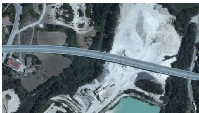
Figure 2. Overview of the viaduct / Foto aerea del viadotto.
