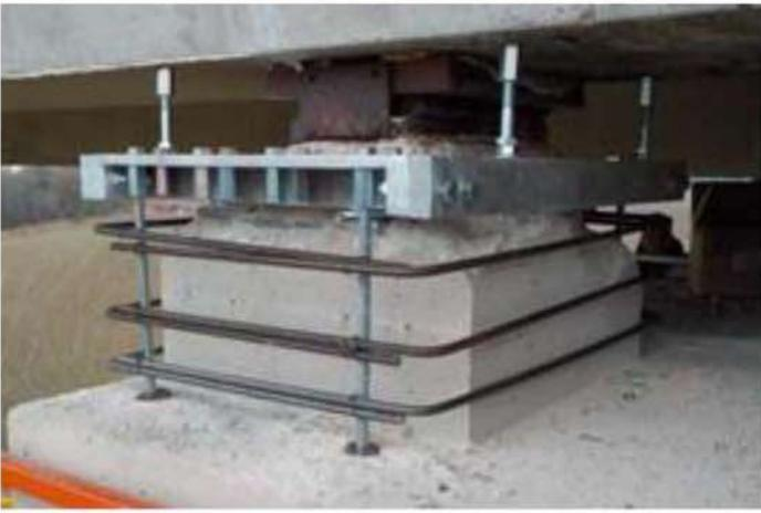
Figure 13. Detail of isolator fixing / dettaglio fissaggio isolatori
