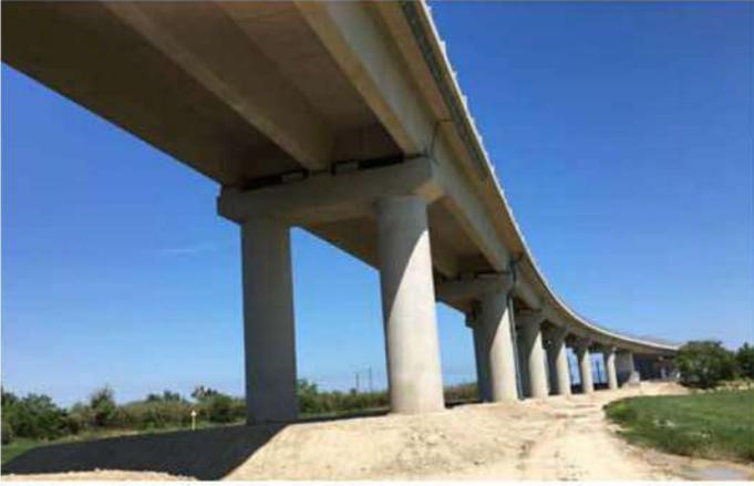
Figure 18. Lateral view after seismic upgrading / vista laterale dopo i lavori di miglioramento sismico
