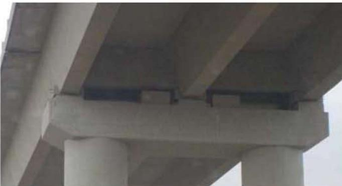
Figure 20. View of transversal end stops / vista dei ritegni di fine corsa
